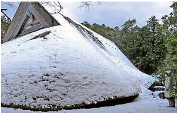
屋根が崩落した上時国家住宅（北國新聞2024年1月9日）
